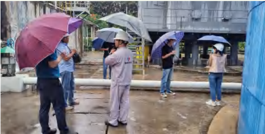
新港热电公司进行“雨水等净化回用”节水项目申报工作，对地表的雨水及活性炭反洗水等净化后回收利用，减少自来水用量
